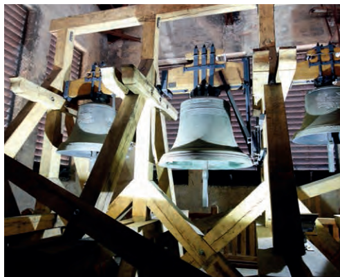
NOVĚ INSTALOVANÉ SCHODIŠTĚ ZPŘÍSTUPNILO KRÁSNÉ ZVONY VE ZVONICI. FOTO J. SEJKORA
